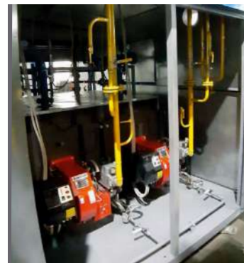
Фармацевтический завод ЮгМедФарм. Котел промышленный наружного размещения двояный WS 1200, 2шт. Ростовская область, х. Калинин.
