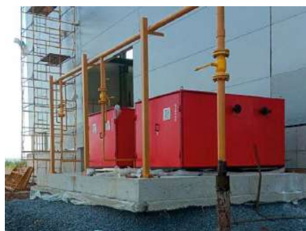
Котлы наружного размещения VS800. Завод Бонум. г. Новочеркасск
