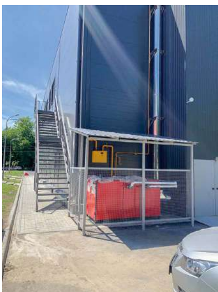
г. Аксай. Здание «Пятерочка». Котел наружного размещения VS 200
