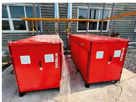
Котел наружного размещения VS150. Молочный завод. г. Ростов-на-Дону
