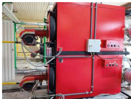
Котел водогрейный W 600.600. Вышневолоцкий ХБК. Тверская область
