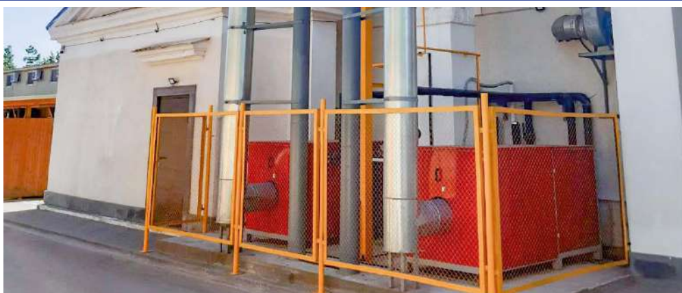
Отель Volga Volga г. Волгоград. Котлы наружного размещения VS200
