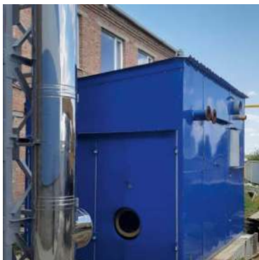
Фармацевтический завод ЮгМедФарм. Котел промышленный наружного размещения двояный WS 1200, 2шт. Ростовская область, х. Калинин.
