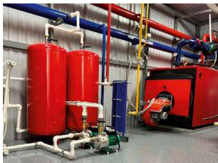
Котел водогрейный W 600.600. Вышневолоцкий ХБК. Тверская область
