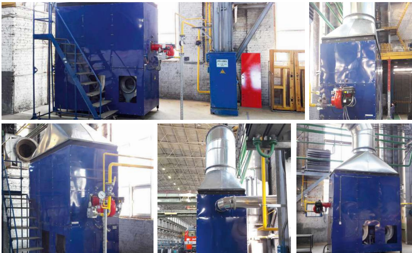
Новочеркасский Электровозостроительный Завод. Воздухонагреватель VT- K 600 г. Новочеркасск.
