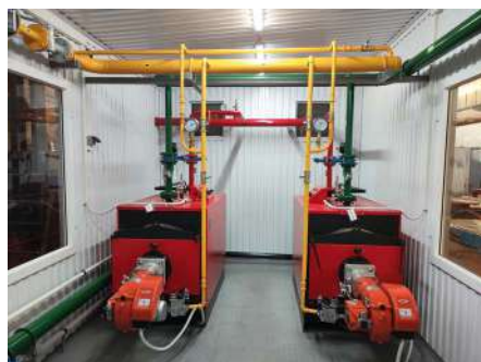
Водогрейные котлы V 250 в котельной установке г. Сызрань
