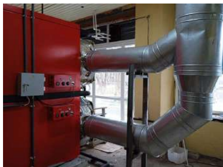
Котел водогрейный W 600.600. Вышневолоцкий ХБК. Тверская область
