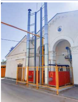
Отель Volga Volga г. Волгоград. Котлы наружного размещения VS200
