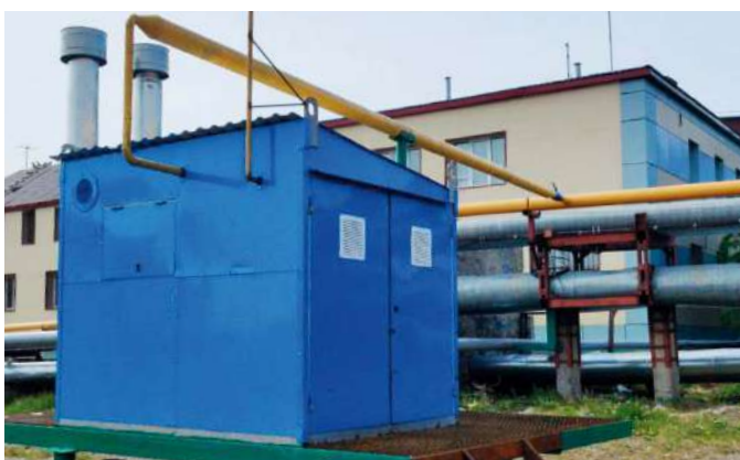
Котел наружного размещения WS 400\400. ООО «ЧСБК». г. Анадырь.
