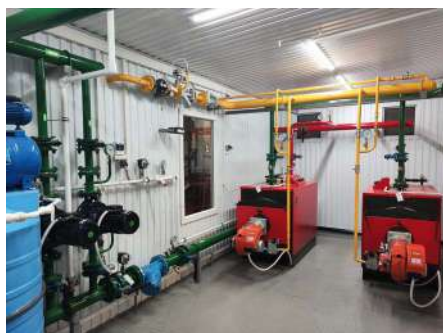
Водогрейные котлы V 250 в котельной установке г. Сызрань
