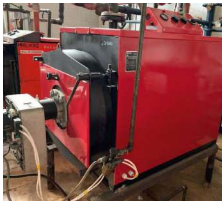
Компания АкваДон. г. Ростов. Котел водогрейный V200
