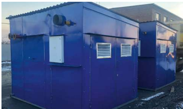
Фармацевтический завод ЮгМедФарм. Котел промышленный наружного размещения двояный WS 1200, 2шт. Ростовская область, х. Калинин.
