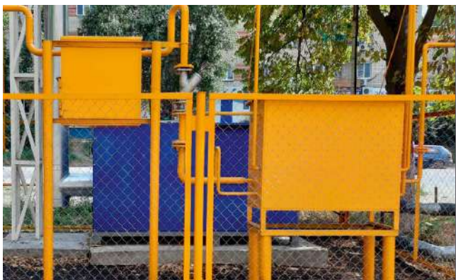
Офисное здание завода «МАГНИТ». Котел промышленный наружного размещения VS 200. г. Новочеркасск.
