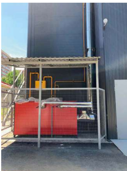
г. Аксай. Здание «Пятерочка». Котел наружного размещения VS 200
